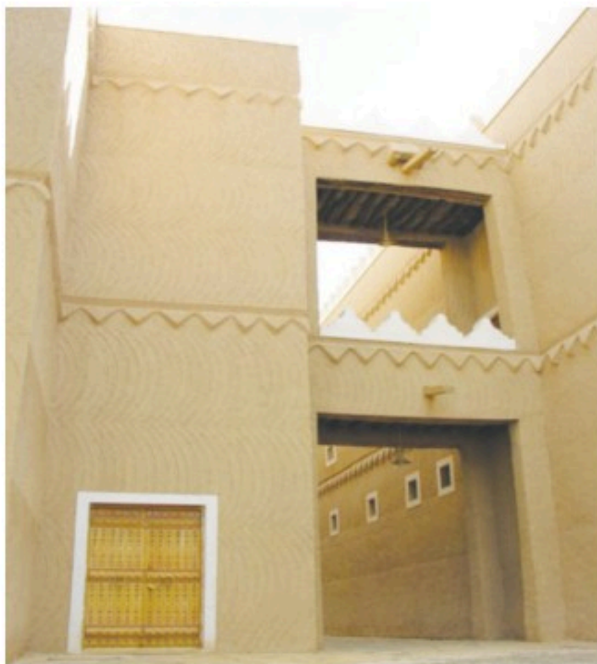
الشكل (٢) البيوت الشعبية في منطقة المربع بالرياض
