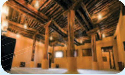
مسجد تاريخي بعد ترميمه
