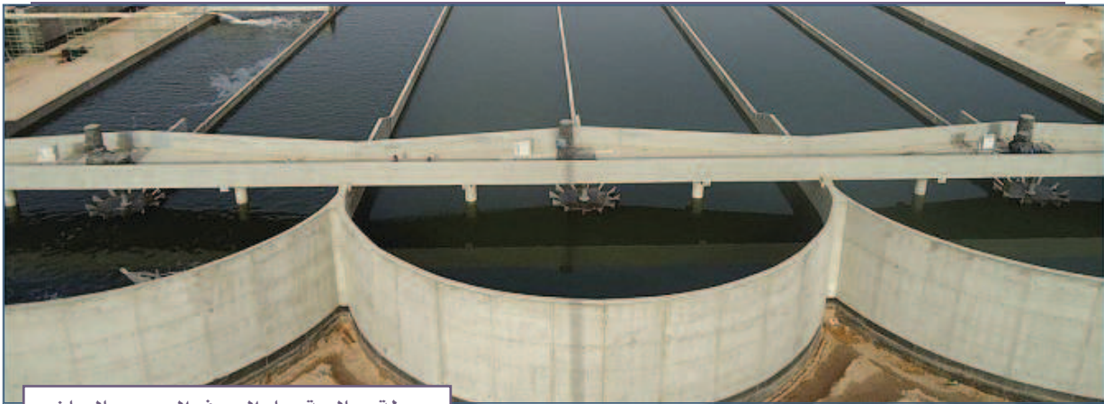
محطة معالجة مياه الصرف الصحي بالرياض
